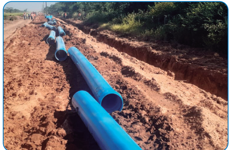
Caños TOM® de PVC-O instalados en el Proyecto del Acueducto del Chaco Central
