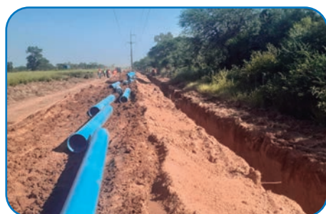
87.800 m de tuberías de PVC-O instaladas
